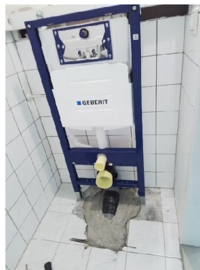
Te maken situatie - Toilet frame met verplaatste afvoer.
