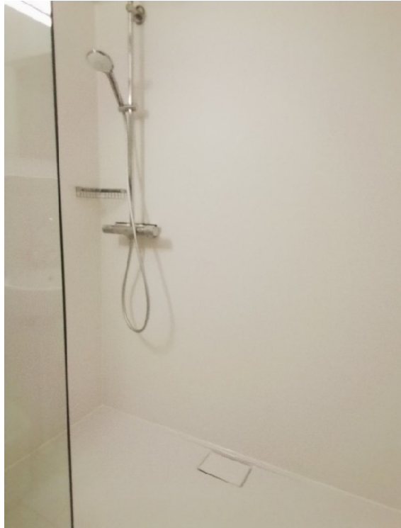
Te maken inloopdouche met afvoergoot.
